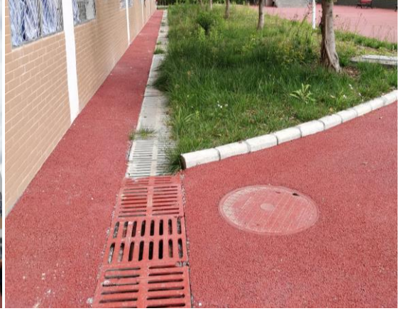
建筑南侧排水暗沟及绿化
